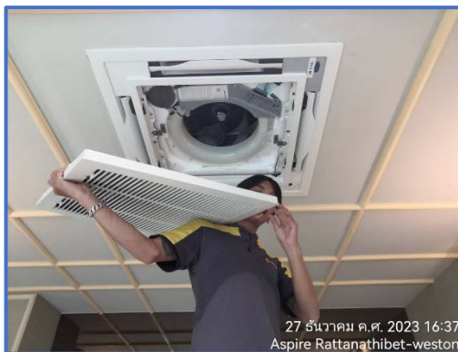
รูปที่ 56 เจ้าหน้าที่ทำความสะอาดเครื่องปรับอากาศ
