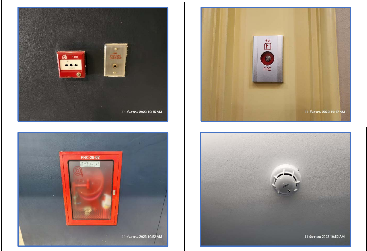
รูปที่ 63 อุปกรณ์ดับเพลิงและอุปกรณ์แจ้งเตือนเหตุฉุกเฉิน
