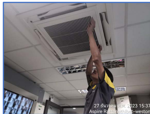
รูปที่ 56 เจ้าหน้าที่ทำความสะอาดเครื่องปรับอากาศ
